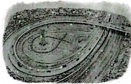
Gambar 2. Kondisi Jalan Saat Hujan
